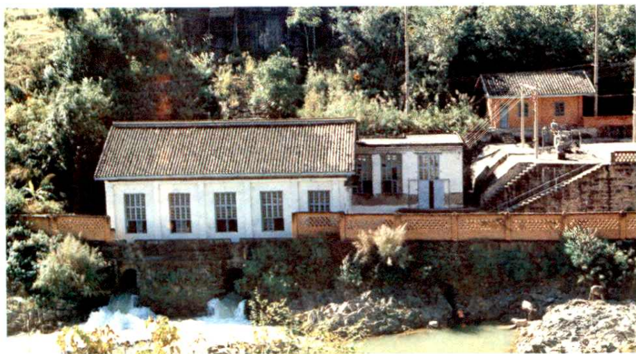
◀ 盐边县“七一”水电站
