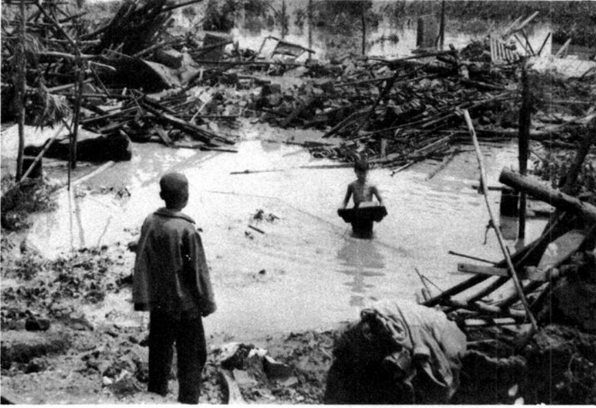
“81.7”洪水淹后社员房屋倒塌的情景。
