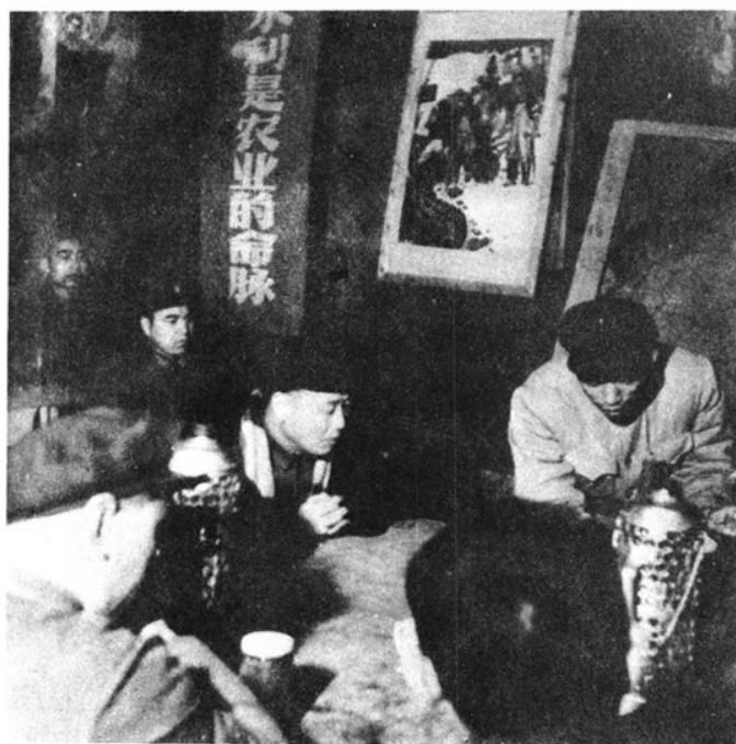
四川省委书记赵紫阳视察三岔水库工地。
