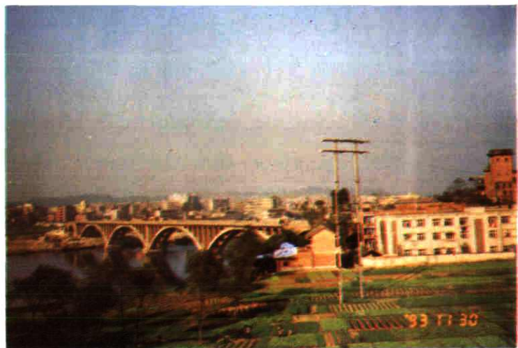
▽ 资阳县沱江大桥
