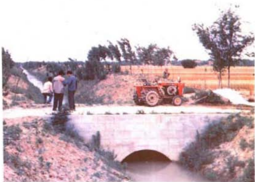
照片30 井、沟结合提灌抗旱淋盐,调控地下水位,综合防治土壤盐渍化,成效显著 (河南延津)
