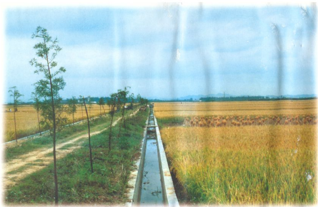
图为惠阳市水口镇优质粮生产示范基地渠系建设一角。
