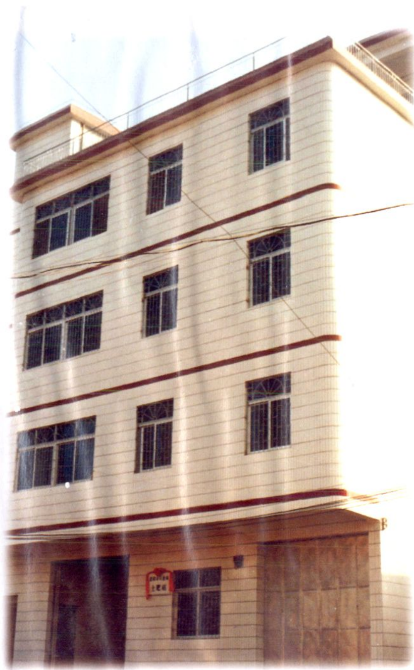
图为惠阳市农业局下属单位——土肥站办公大楼 (位于惠阳矮陂镇)。
