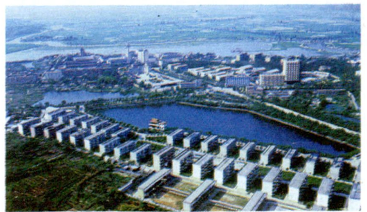
九江市水利水电建筑公司与共青城一起成长，这是八十年代承建的共青城住宅花园。
