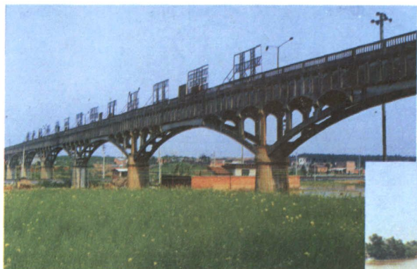
德安米粮铺渡槽（建于七十年代）
