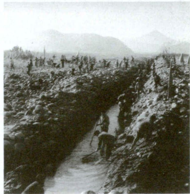
七十年代中期，本市广泛开展了农业学大寨水利化运动，这是当时武宁石门楼乡改修石门河情形。
