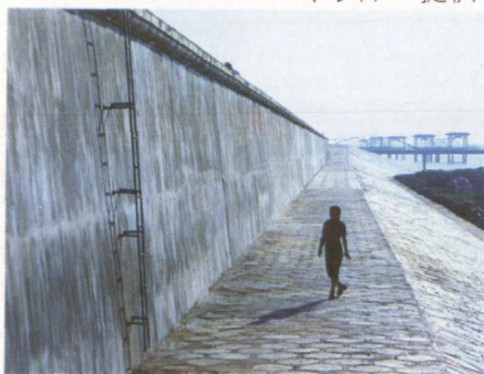
一九九九年，九江长江大堤开始大规模整治，耗资19.5亿，这是新建城市标准防洪堤段。
