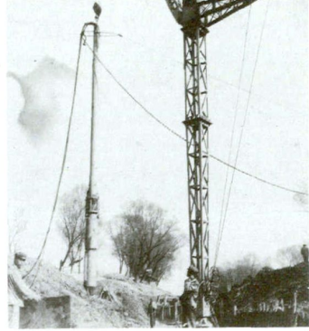
80年代中期后，九江水利建设广泛采用振动水冲加固地基技术，这是长江永安堤施工现场。徐仲兴 提供
