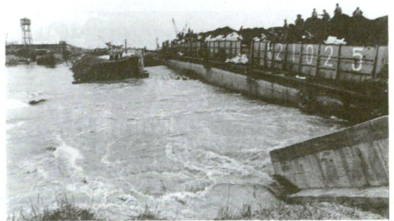
1998年8月7日下午，九江长江大堤4—5号闸口处决口后，市政府紧急调来船只堵口，这是煤船甲21025号堵口时情形。
