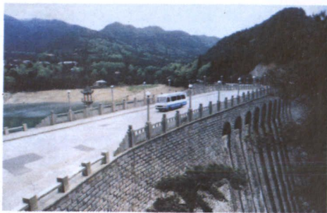
庐山水库大坝，该水库目前开辟为国家重点旅游景点。
