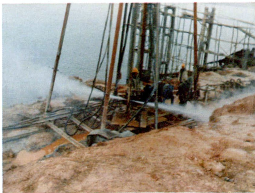
80年代中期，九江水利工程广泛采用“高压喷灌技术”，这是当时云山水库施工现场。
