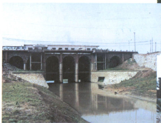
龙开河上游拦水闸（1970年建）
