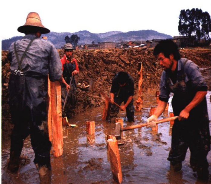
大街挡墙基础人工打桩
