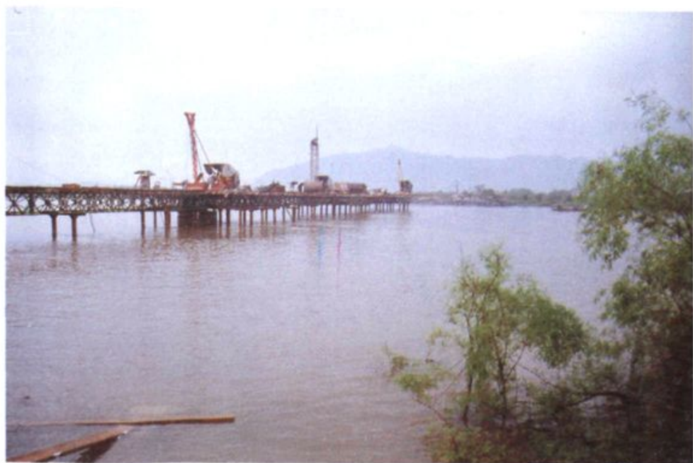
正在建造中的南港大桥
