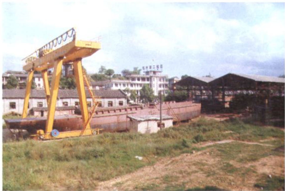
福州第二船舶修造厂五百吨级滑道船台一角
