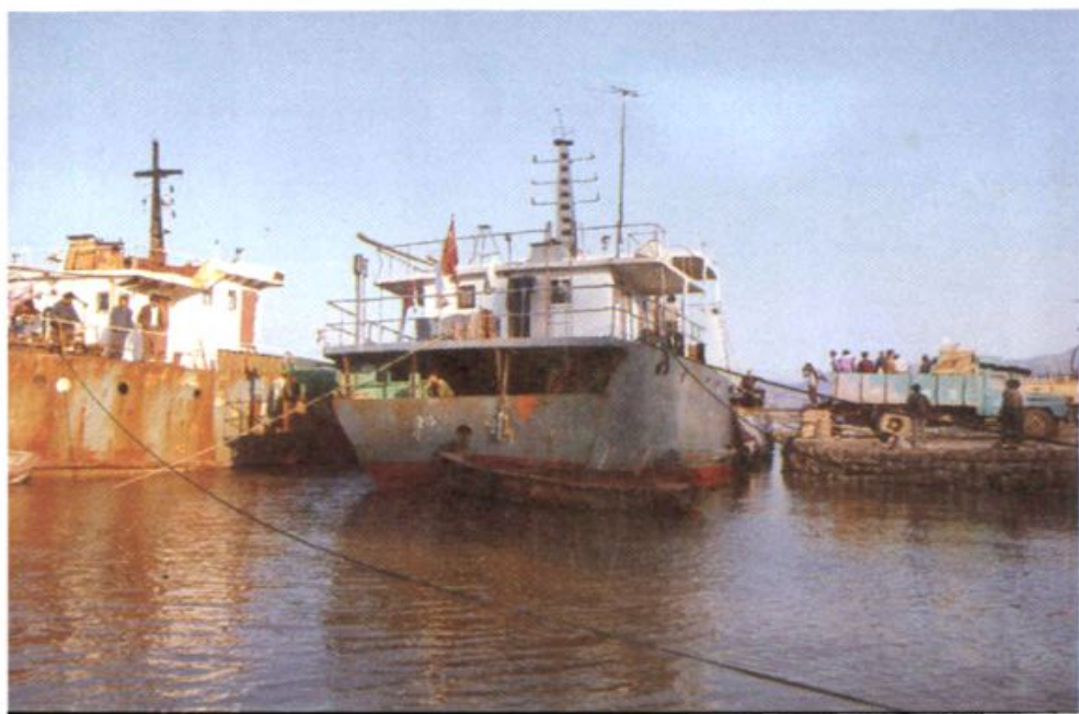
枕峰港岷南货运码头一角
