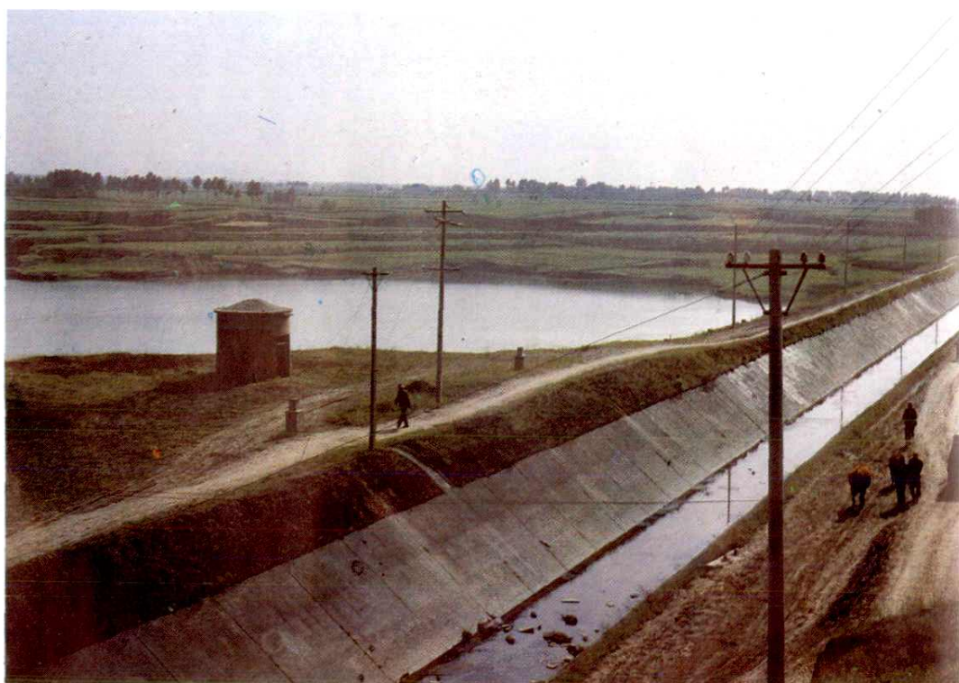
孔头沟渠库结合工程
