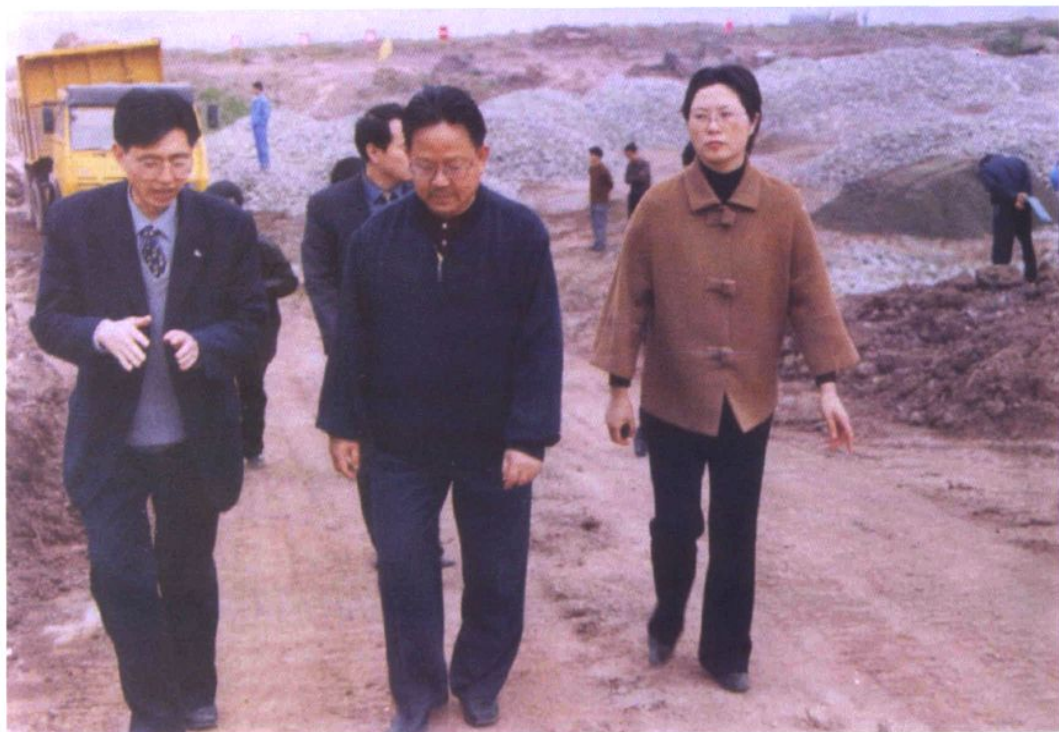
水利厅副厅长谢正荣视察渠江堤防工程
