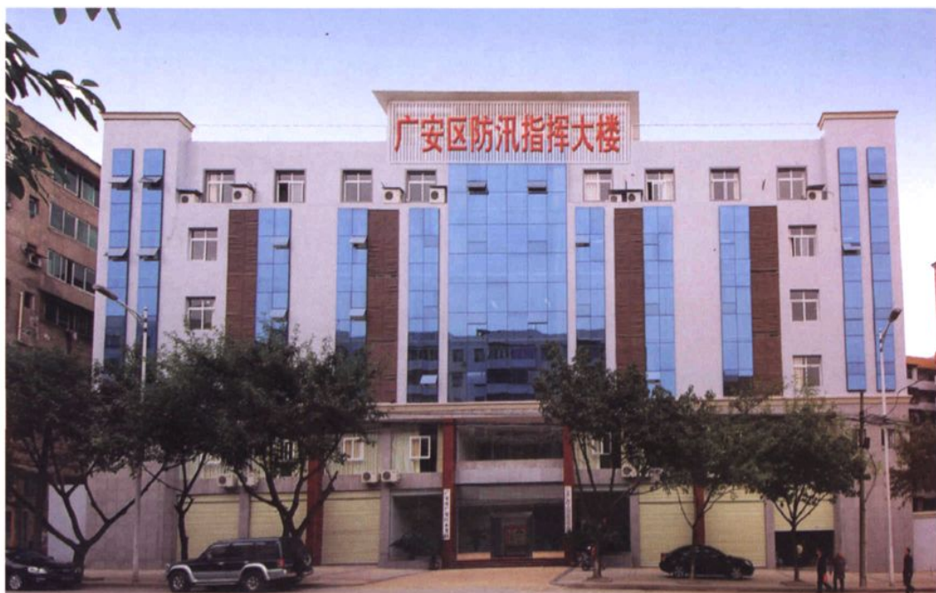
广安区水务局新办公楼（建设路42号），2009年10月投入使用
