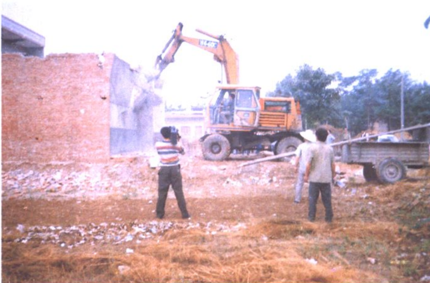
依法拆除违法占地建筑物
