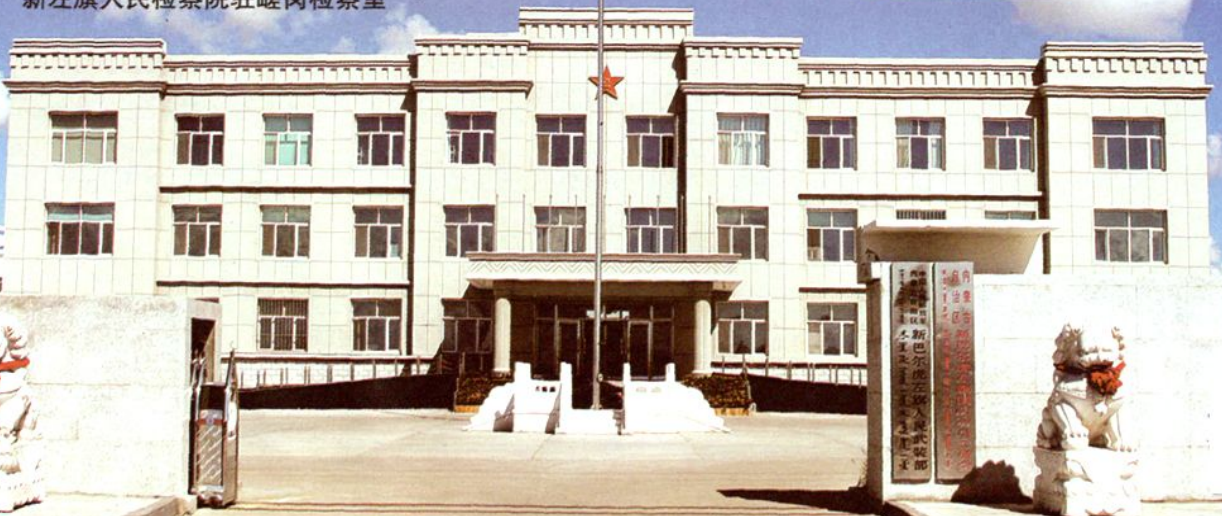
新左旗人民武装部办公楼
