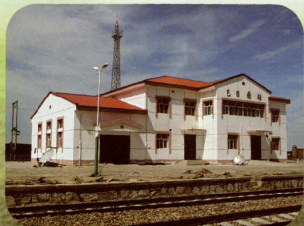
两伊铁路巴日图站
