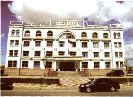
新左旗人民法院办公楼
