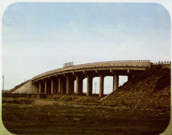
滨洲铁路线嵯岗立交桥
