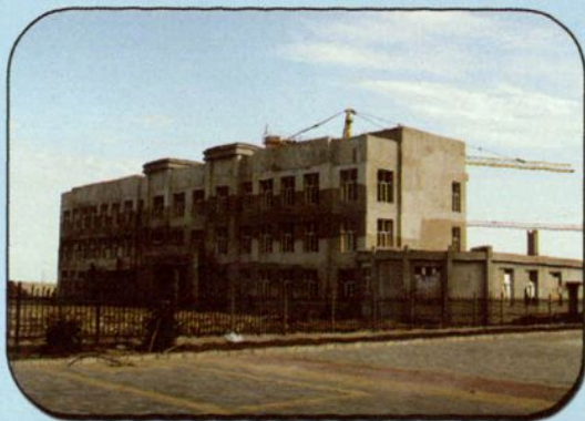
建设中的嵯岗幼儿园
