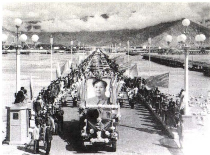
1965年西藏自治区成立前夕，在拉萨河上新建的永久性钢筋混凝土大桥正式通车。
