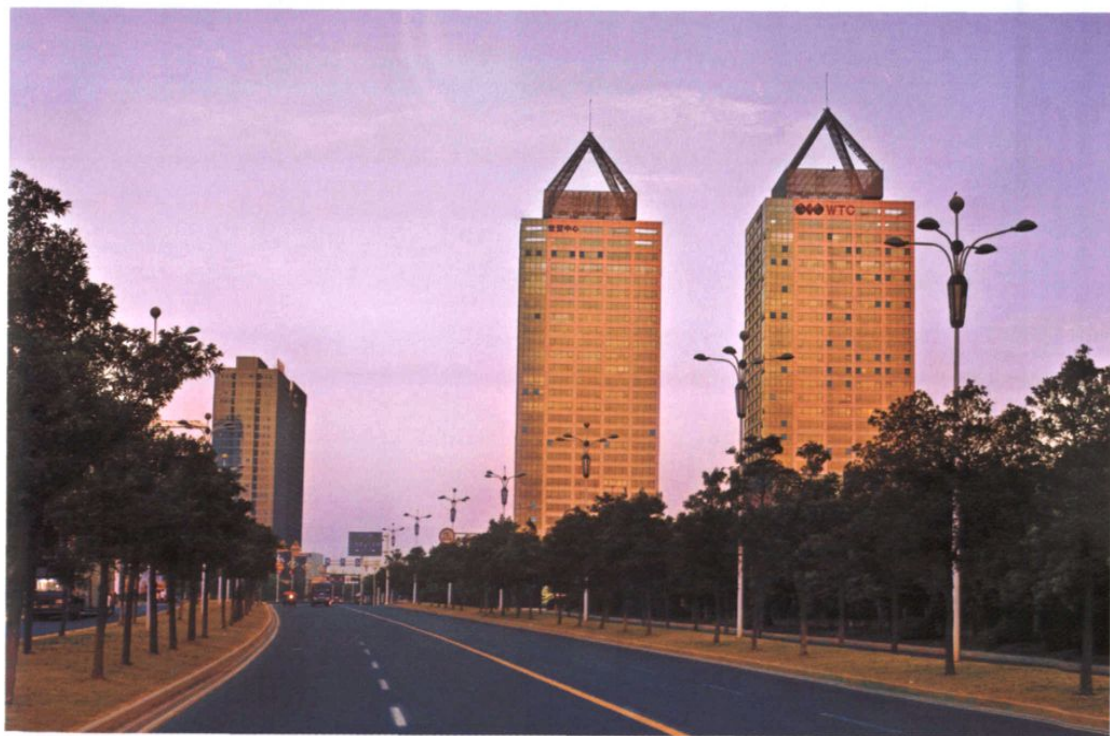
位于武进城区的世贸中心
