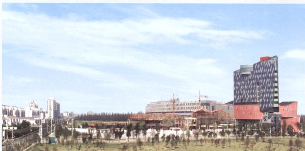
建设中的江苏武进经济开发区
