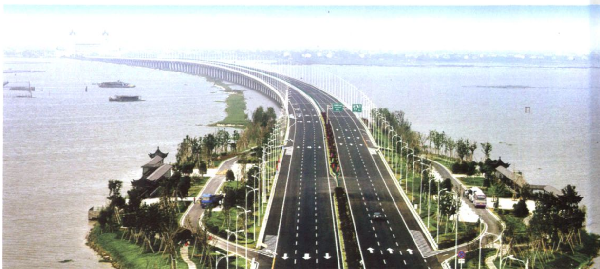
宁太高速公路太湖大桥
