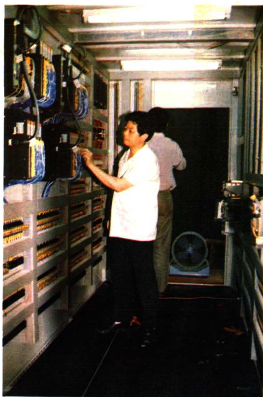
△机电分厂安装大型控制设备
