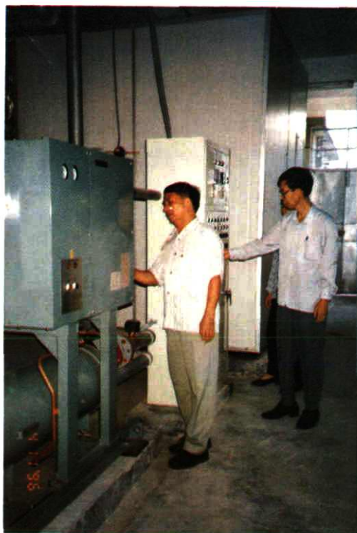
△洁净中心技术人员在调试空调系统主体设备。
