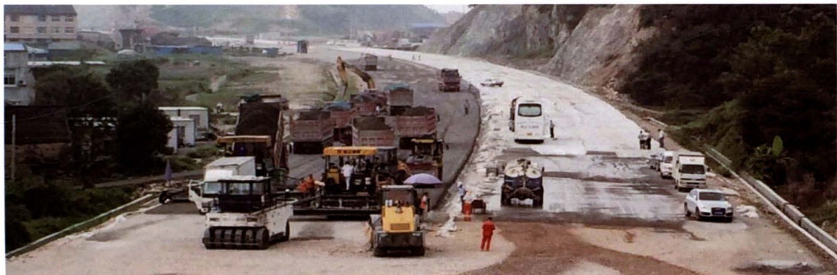
新83公路工地现场
