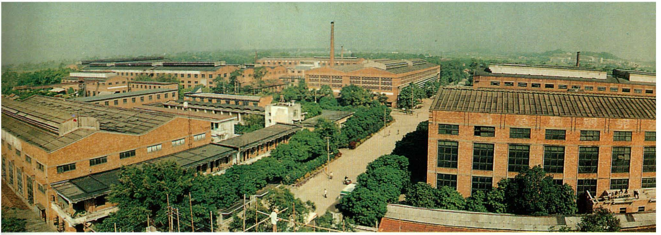
▲南宁重型机器厂厂区
