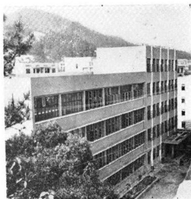
建德县麻园小学
