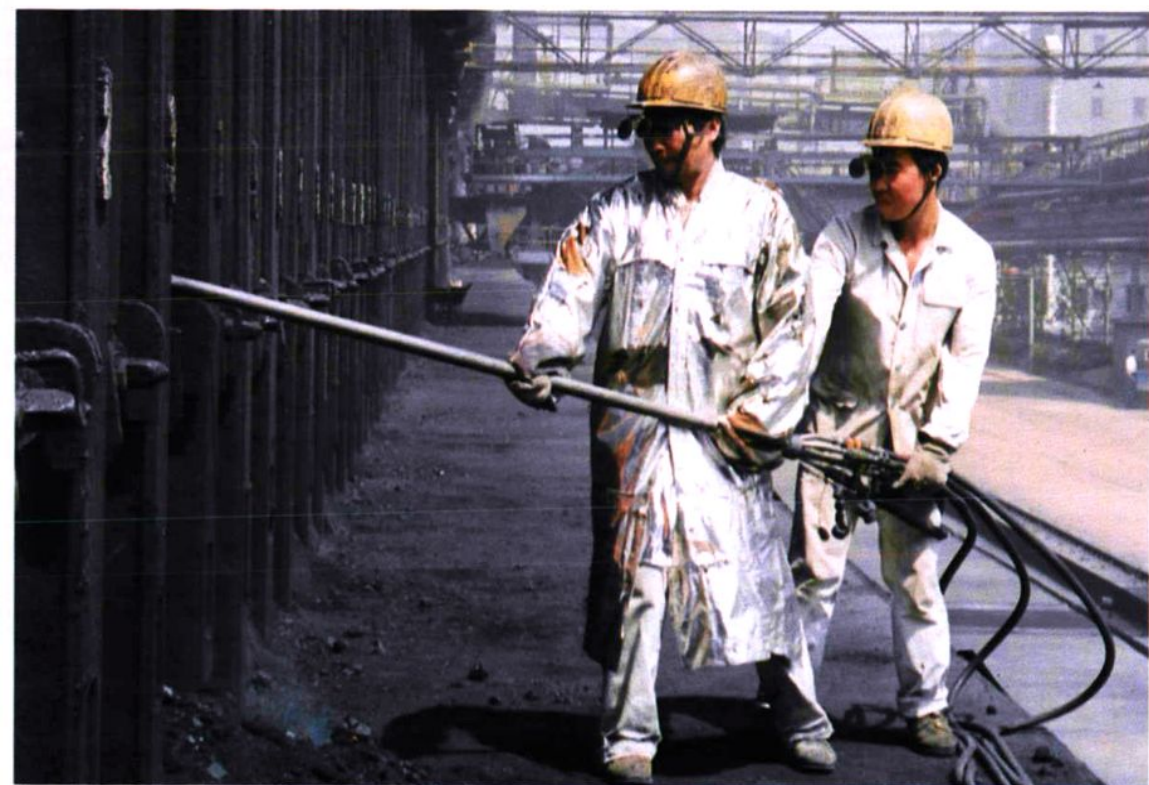
焦炉炉墙修补采用火焰喷补技术
