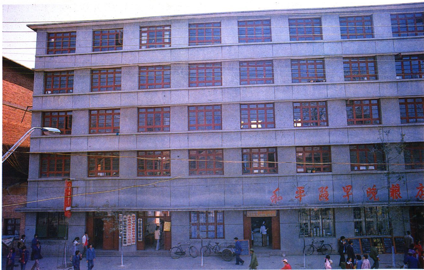
个旧市粮食局办公大楼
