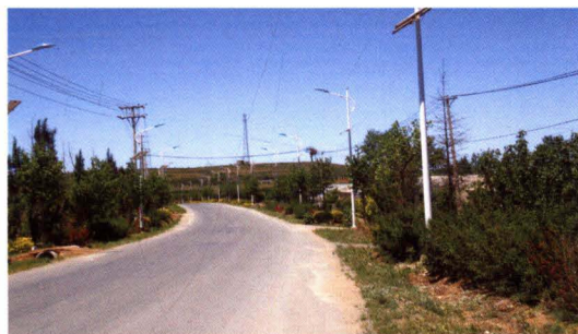
村路亮化工程
