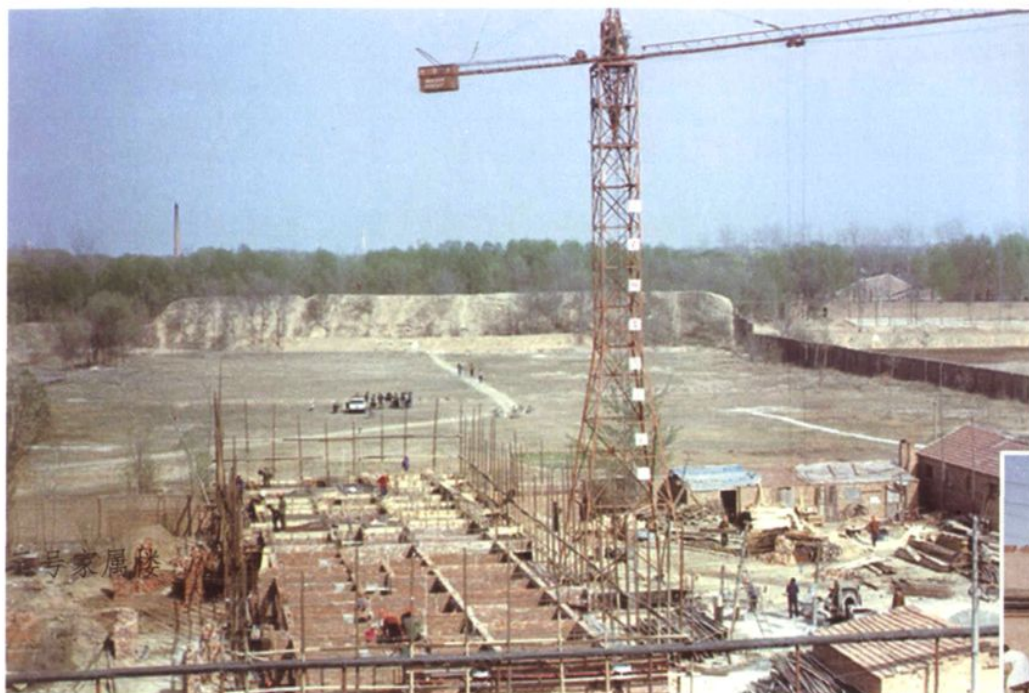
建院初期的建筑工地
