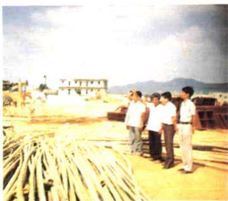
泉州市僑辦領導檢查僑建工程
