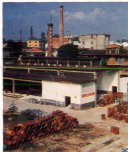
德化(林業)化工廠(原松香廠)
