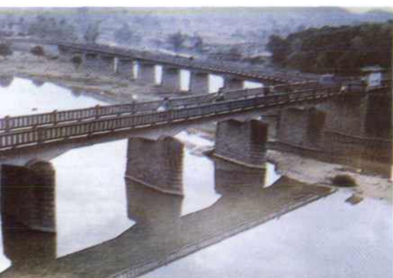
安溪蘆汀丁字橋
