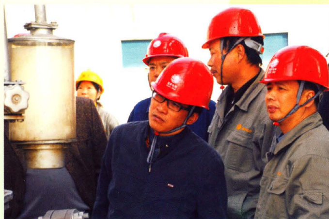
2007年11月18日，鄂州供电公司副总经理黄松泉（前左一）在220千伏郎家畈变电站检查工作
