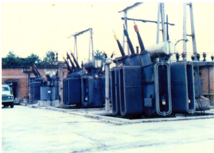
鄂城变电站主变组装（1965年）
