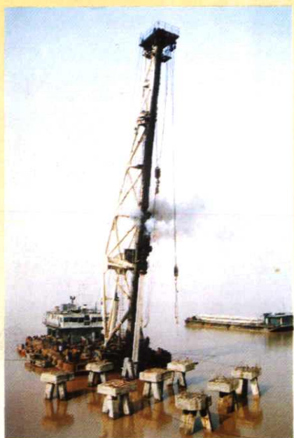
盖北码头施工
