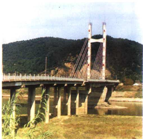
章镇独塔斜拉桥
