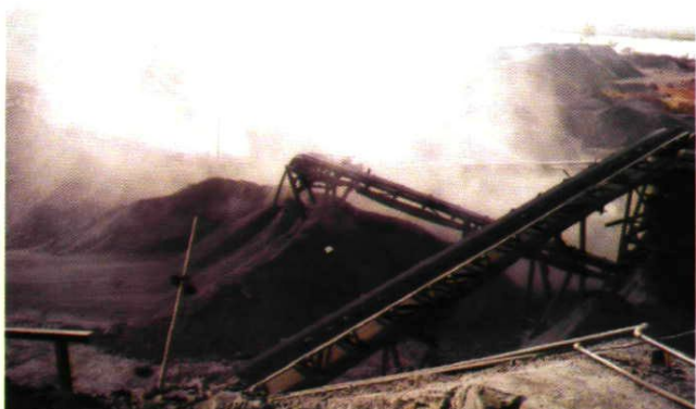
弘禹公司石料生产加工现场
