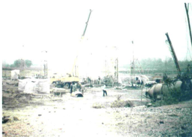
1998年11月，庙头低闸重 建工程桩基施工现场。
