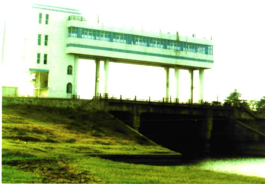
改建加固后的民乐闸全景
