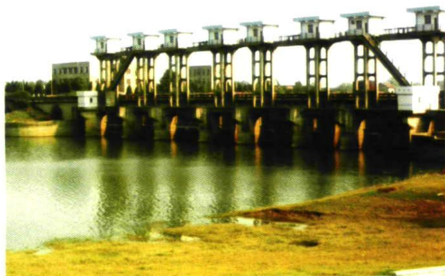
整险加固后的新沟闸全景
