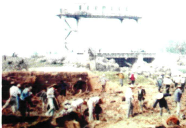
1998年12月，民乐闸改建 加固施工现场。
