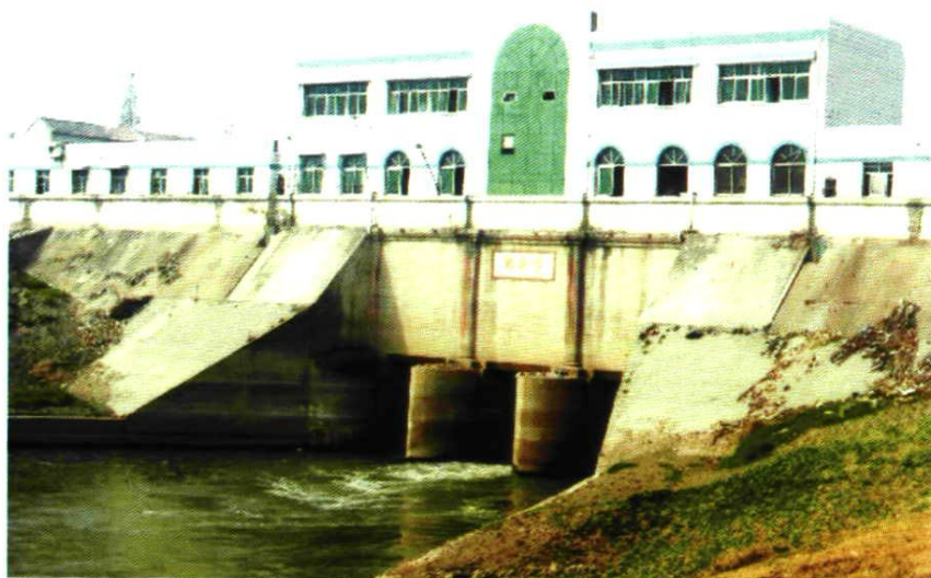
改建加固后的汉川闸全景
