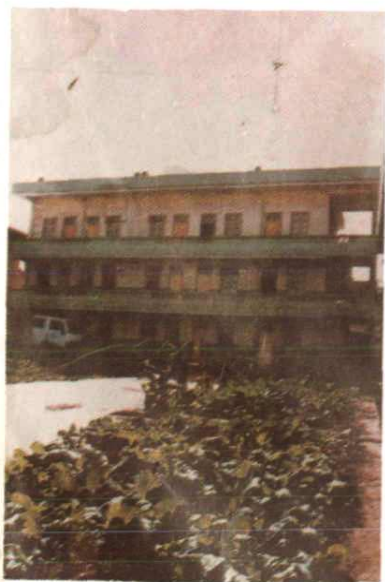
倘甸镇水管站
