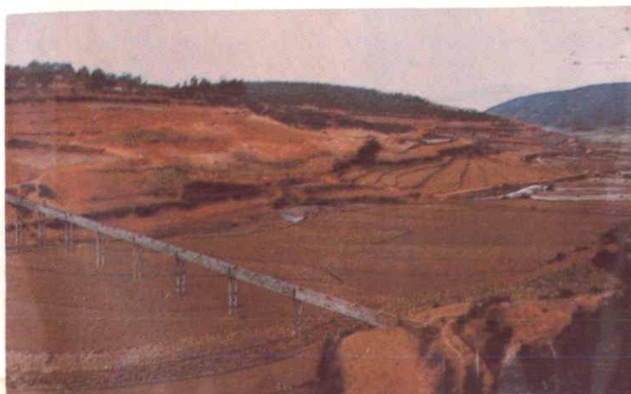
李家管西干渠渡槽
