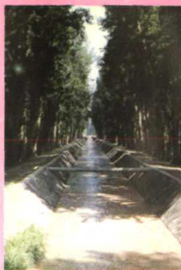
惠民北渠渠貌
