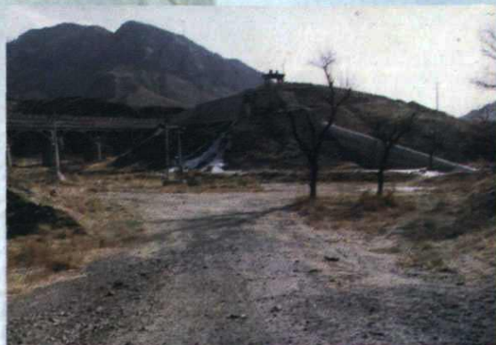
水电工程处承建的水电站工程
