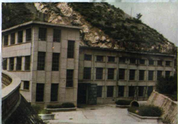
长梁山水电站机房
