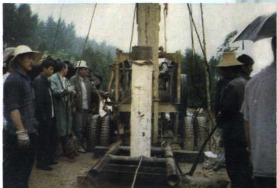
机井队承建机井完工下管
