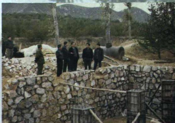
栾庄乡厂村山区饮水工程
