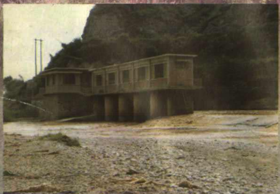
桑南渠渠首引水闸
