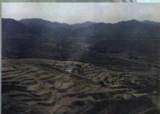
相广河流域梯田工程
