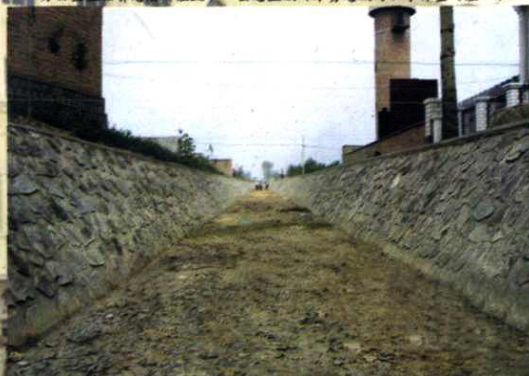
桑南灌区防渗工程
