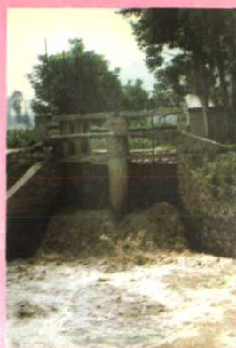
惠民北渠泄水闸
