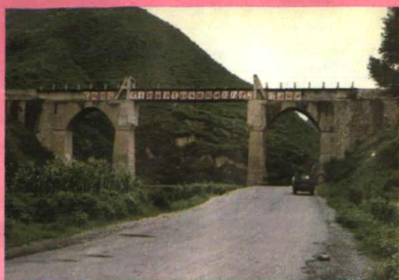
劈山大渠 武家沟渡槽
