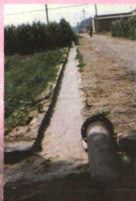
惠民北渠防渗渠工程
