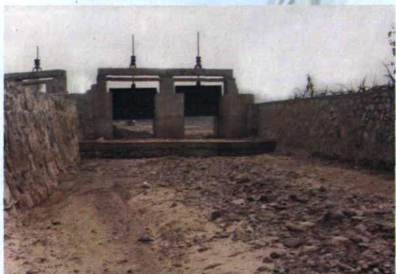
窑子头引洪淤灌工程
