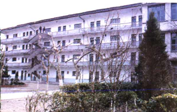
龙泉一中的教学大楼。
