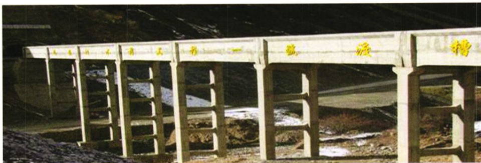
玛依河水利工程第一渡槽
