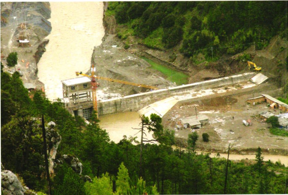
玛依河水利工程拦河坝
