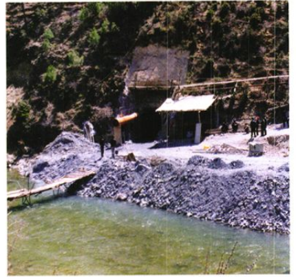
玛依河水利工程马鞍山隧道进口
