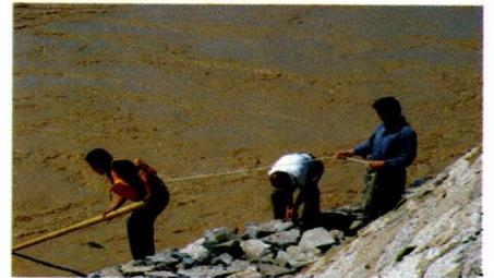
汛期，滨州黄河职工对险工、控导工程根石、坦石进行探摸
