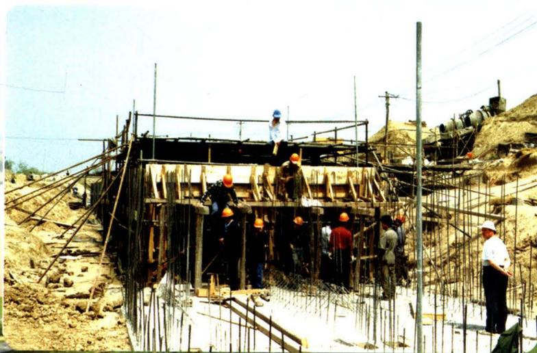
引黄闸洞身出口段施工
