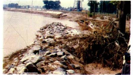
“96.8”洪水期间，小街控导工程被洪水冲毁
