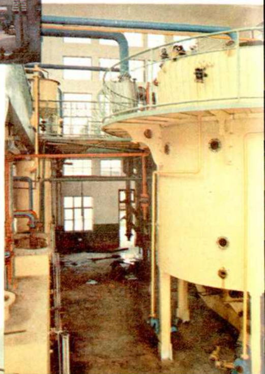
油化厂浸出车间一角
