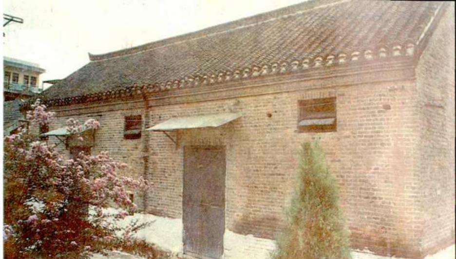
解放初期利用民房 改造的旧式仓房
