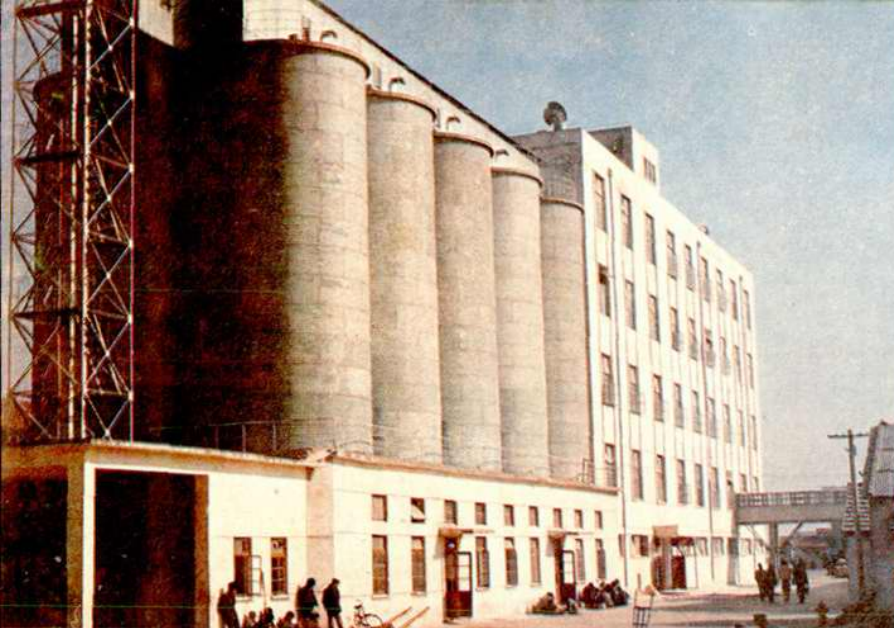
面粉厂钢板仓
