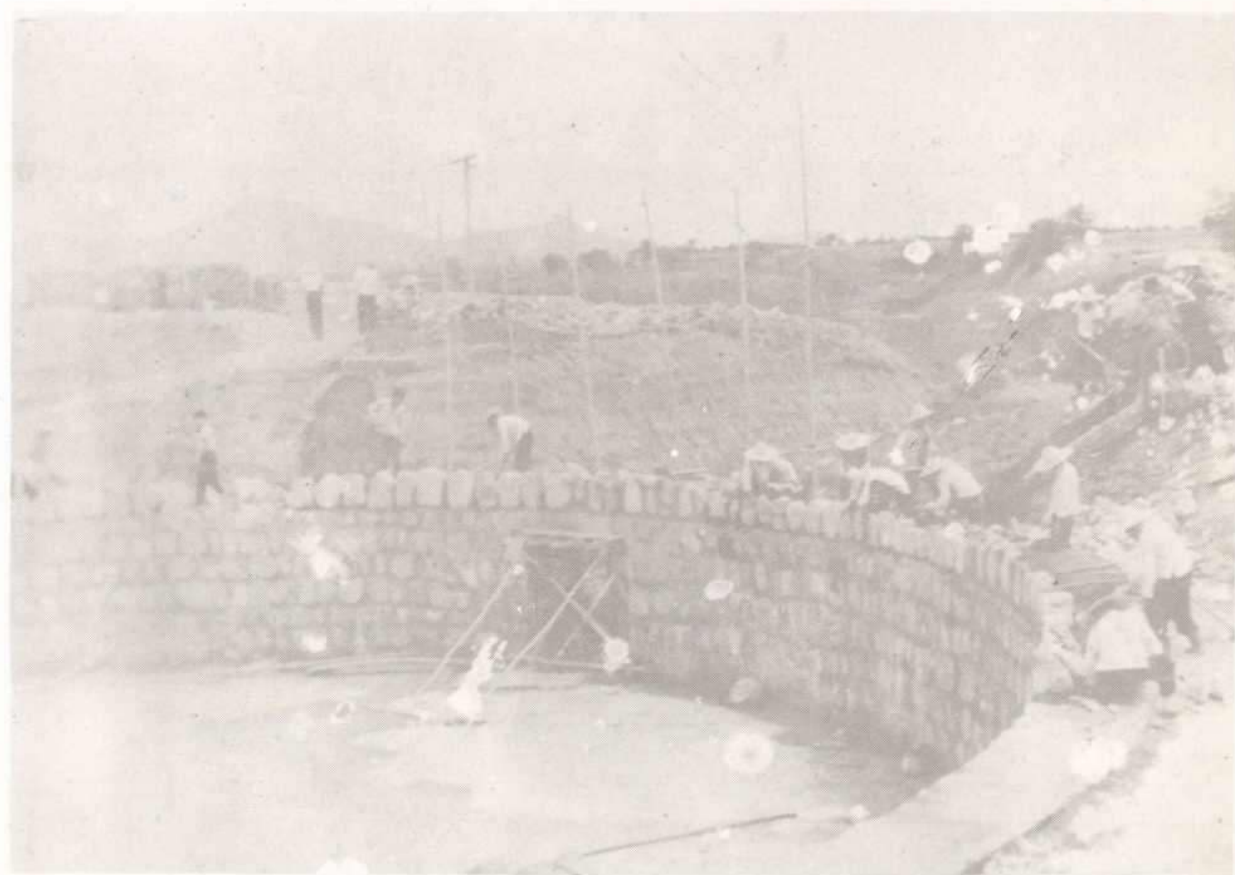
覆土油罐土石方工程
