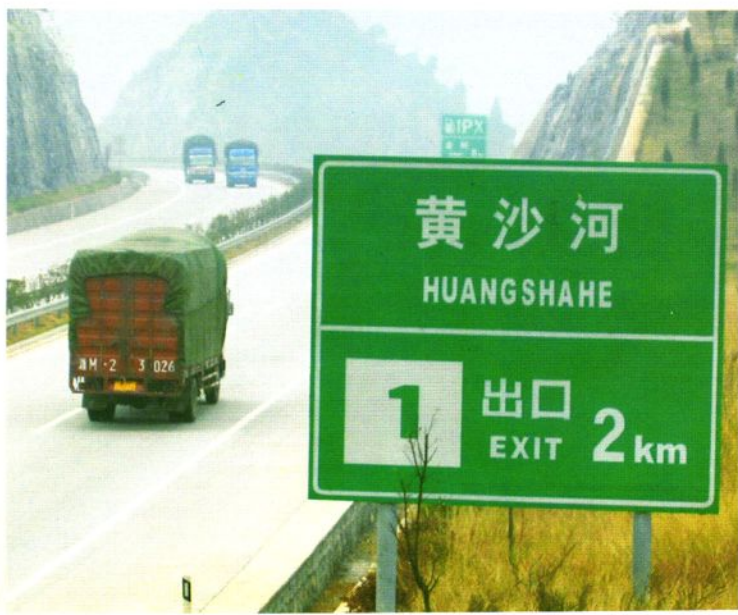
穿过全州境内的高速公路一角
