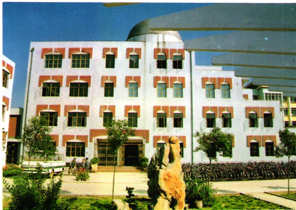
◀ 济宁市第一中学综合实验楼
