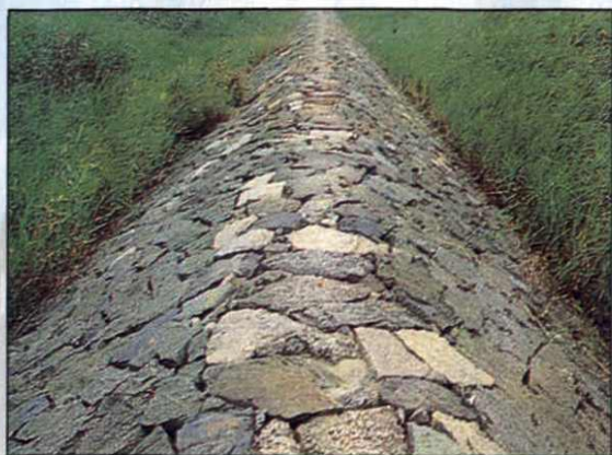
崇明促淤工程——团结沙锁坝 Chongming accretion project——Tuanjiesha groin for restriction
