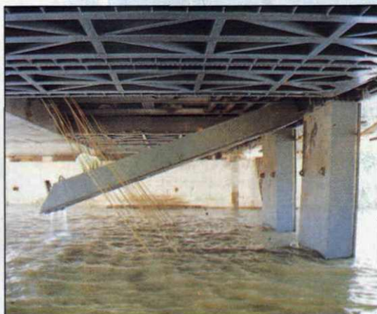
正在启闭中的悬挂式闸门 Suspended-type gate is opening
