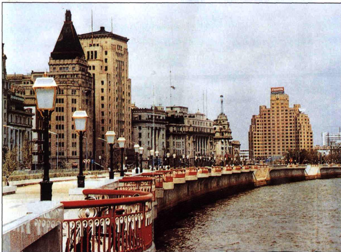
改建后的外滩厢式防汛墙 (1993)
