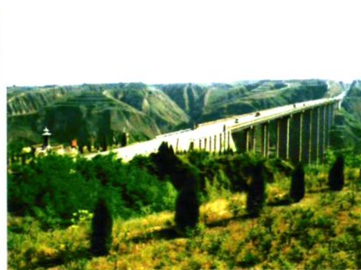
金水沟大桥（108国道）
