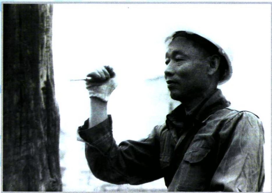
▲ 湖南省劳动模范鲁志文为杉木电杆去腐涂油
