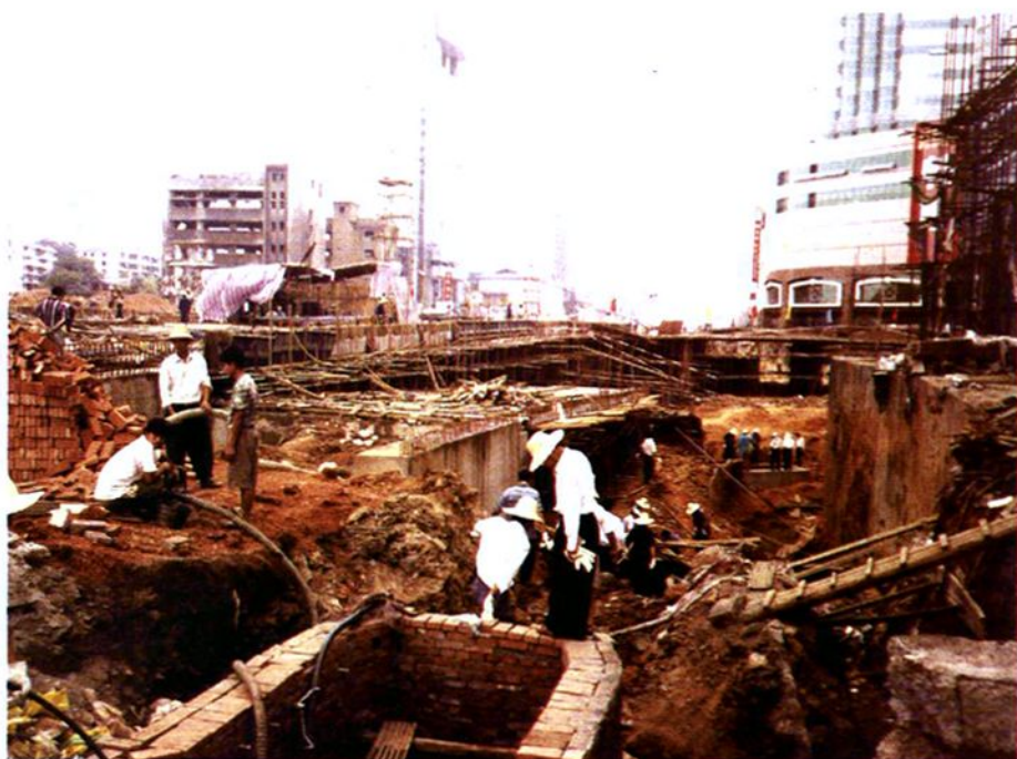
▲ 2000年长沙市五一路扩建,严重威胁长沙—南宁等四条光缆线路的安全,长沙线路局派出工程技术人员配合五一路扩建工程施工,有效地确保了线路畅通。
