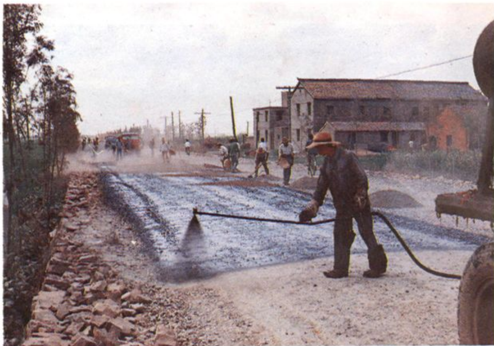
沥青(渣油)路施工现场
