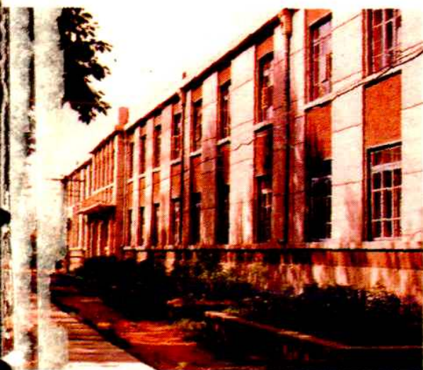
呼盟医药、药材采购供应 站(原呼盟医药分公司)办公 楼
