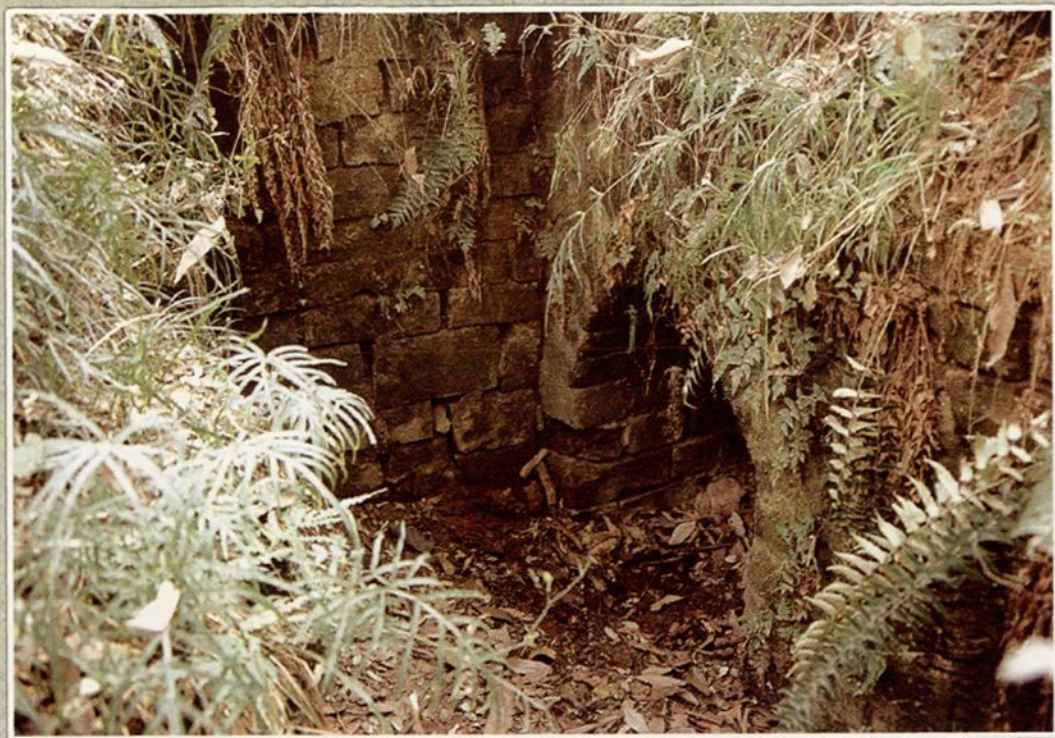
石头城段包山墙内侧汇水暗沟入口
