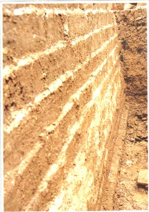
通济门段城墙底部勒脚
