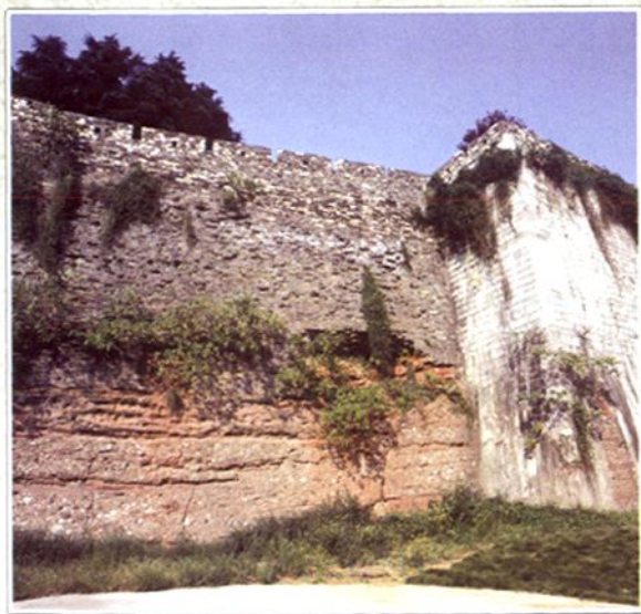
砖墙与条石墙接合部(清凉门段)
