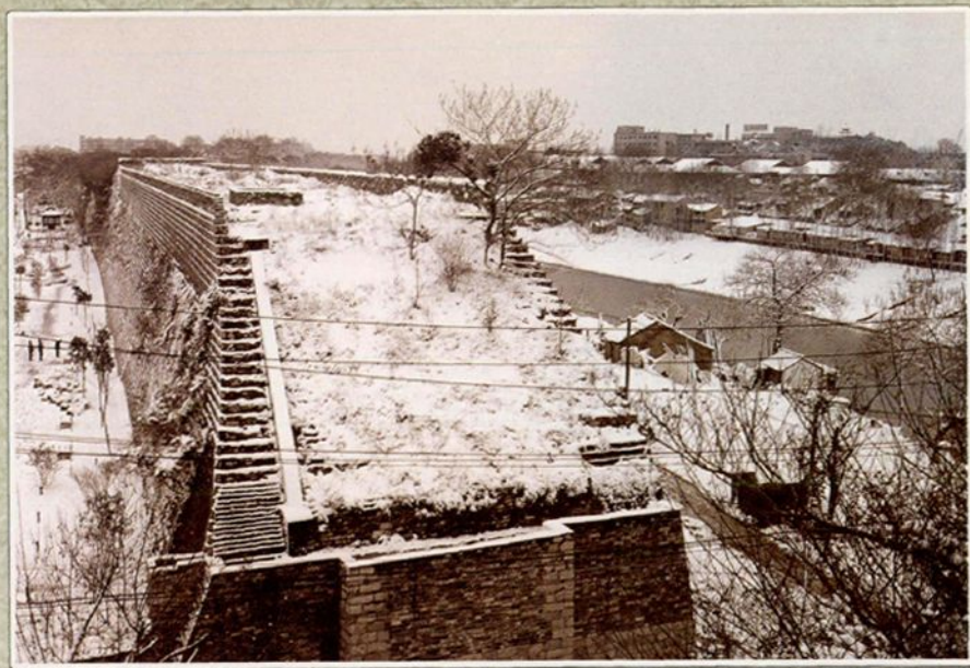
拆除中华东门留下的豁口
