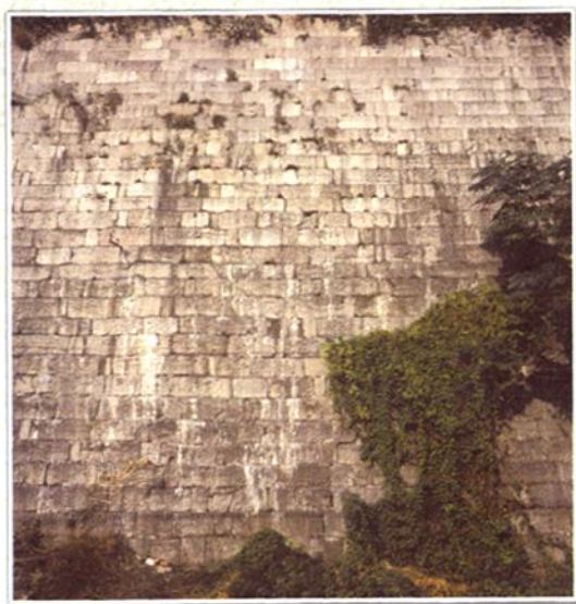
武定门段条石墙
