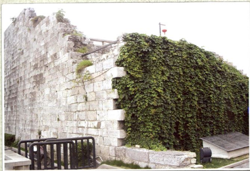
维修后的东水关城墙断面
