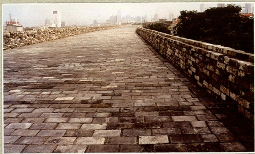
维修后的集庆门段城顶
