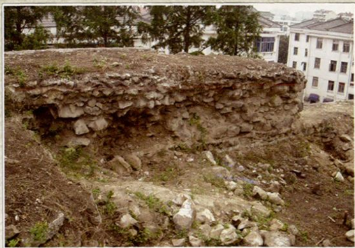
条石墙内部结构
