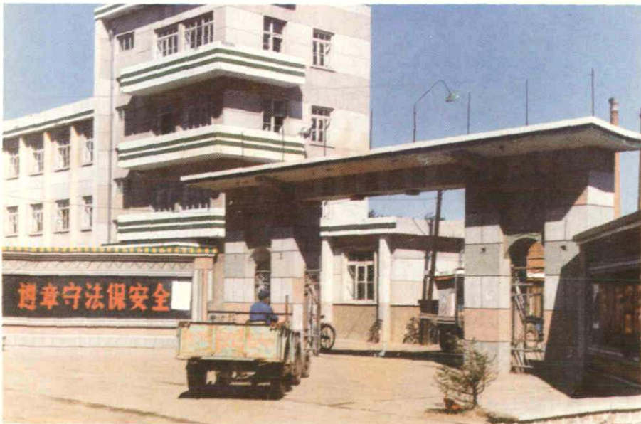
第一粮库办公楼一角
