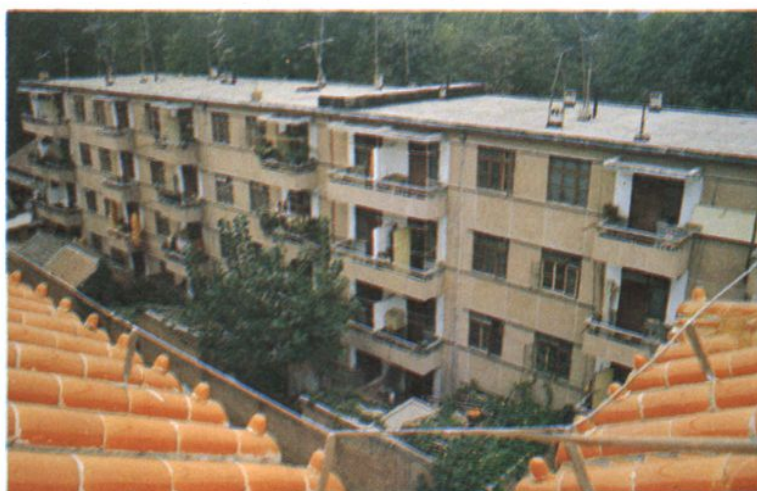
洛宁县烟草公司职工宿舍大楼一角
