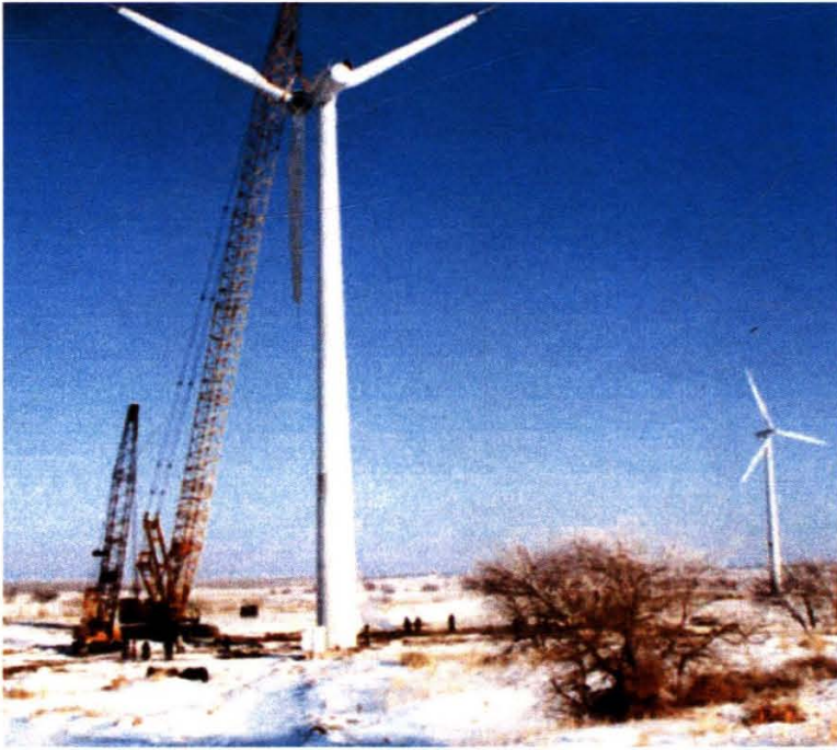
通榆风力发电场发电机 组机头风叶吊装
