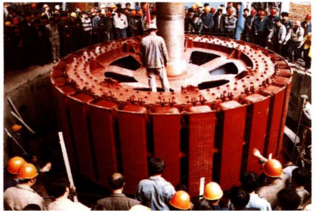
松江河发电厂小山电站发电机转子吊装就位
