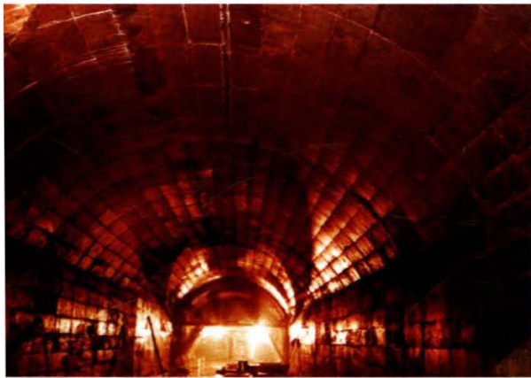
松江河发电厂 12.63 千米松山引水隧洞施工
