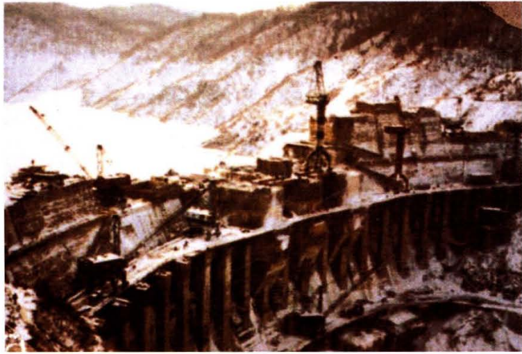
白山发电厂三心园混凝土重力拱坝冬季施工
