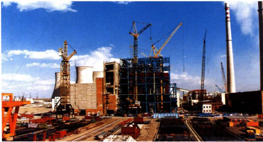
双辽发电 厂3、4号机组施 工现场
