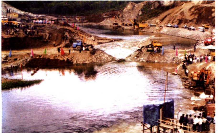
松江河发电厂 松山引水工程大江截流
