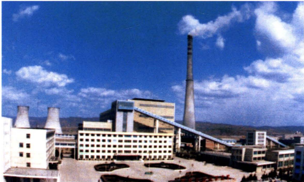
地处祖国边陲，距煤矿仅 1.5 公里的坑口火电厂——珲春发电厂
