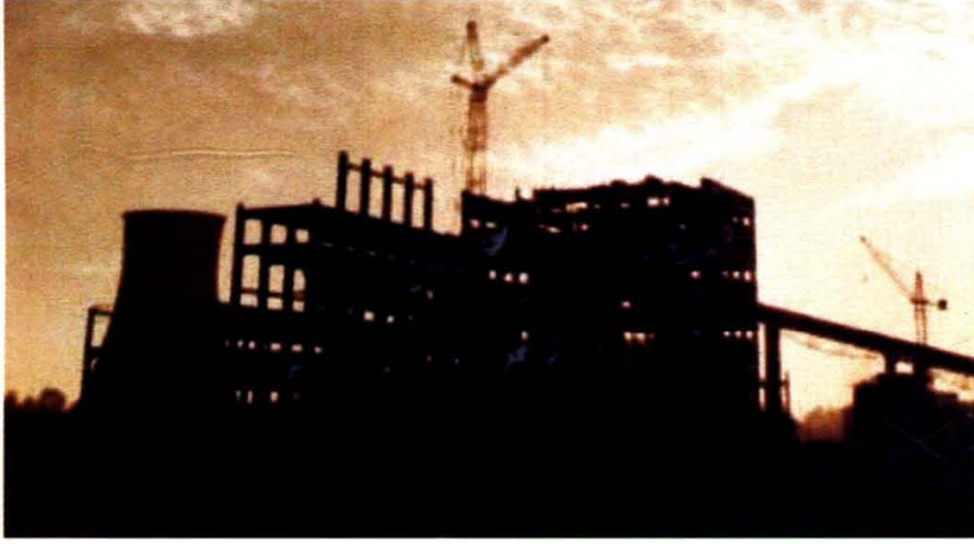
施工中的长 春热电二厂主厂 房框架
