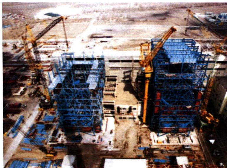
双辽发电厂 3、4号锅炉钢架 吊装
