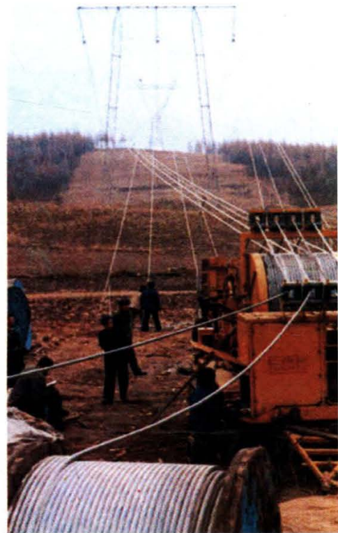
500 千伏输电线路正在 进行张力放线
