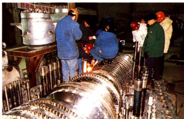
双辽发电厂 30 万千瓦汽轮机高中 压缸扣盖前质量检查
