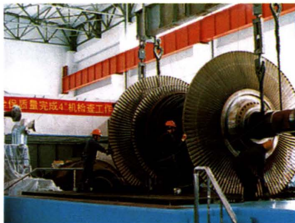
双辽发电厂 4 号汽轮机转子就位
