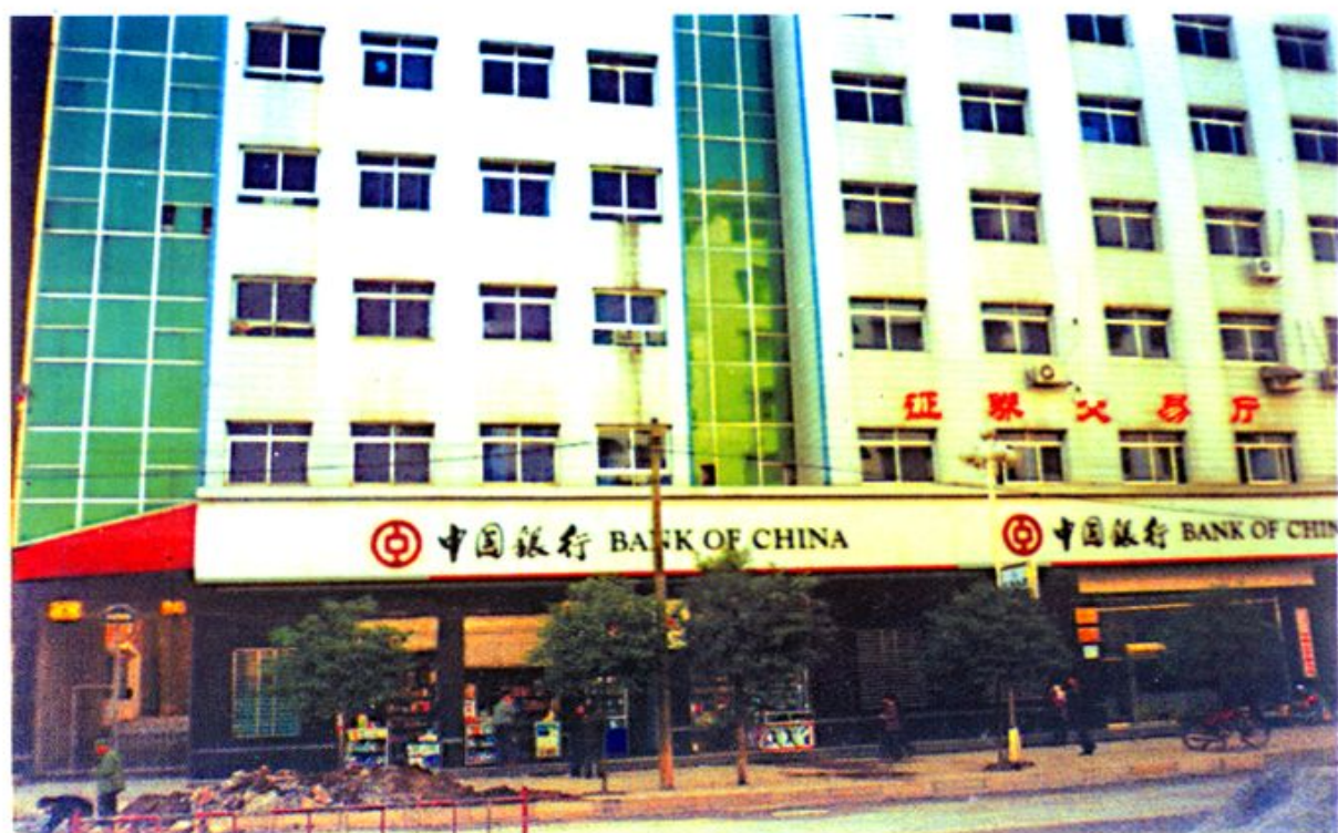
县中国银行营业部大楼
