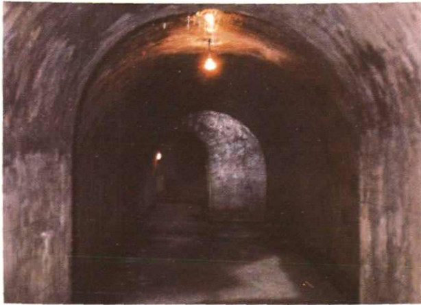
矿务局地下防空洞
