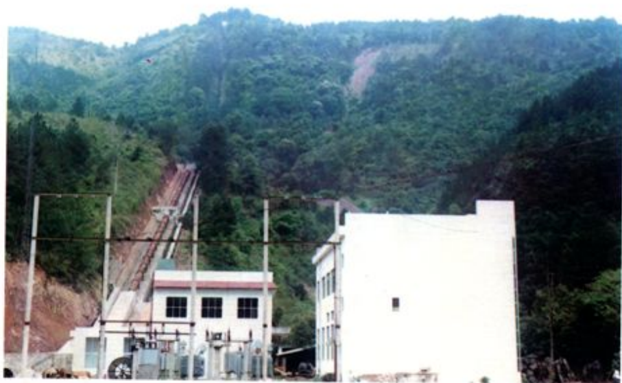
◀ 金秀县河口水电站
