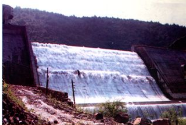
▲象州县罗脉河水电站
