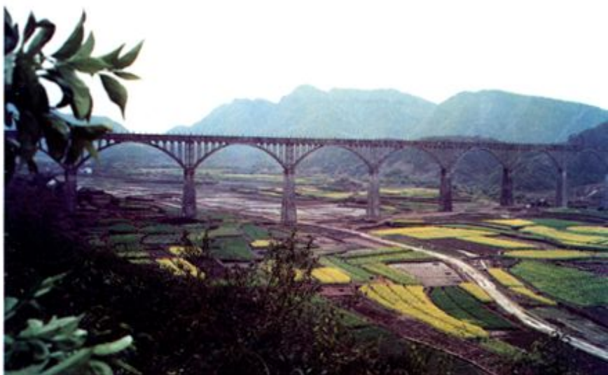
▶融安县石门水库马祖坪渡槽
