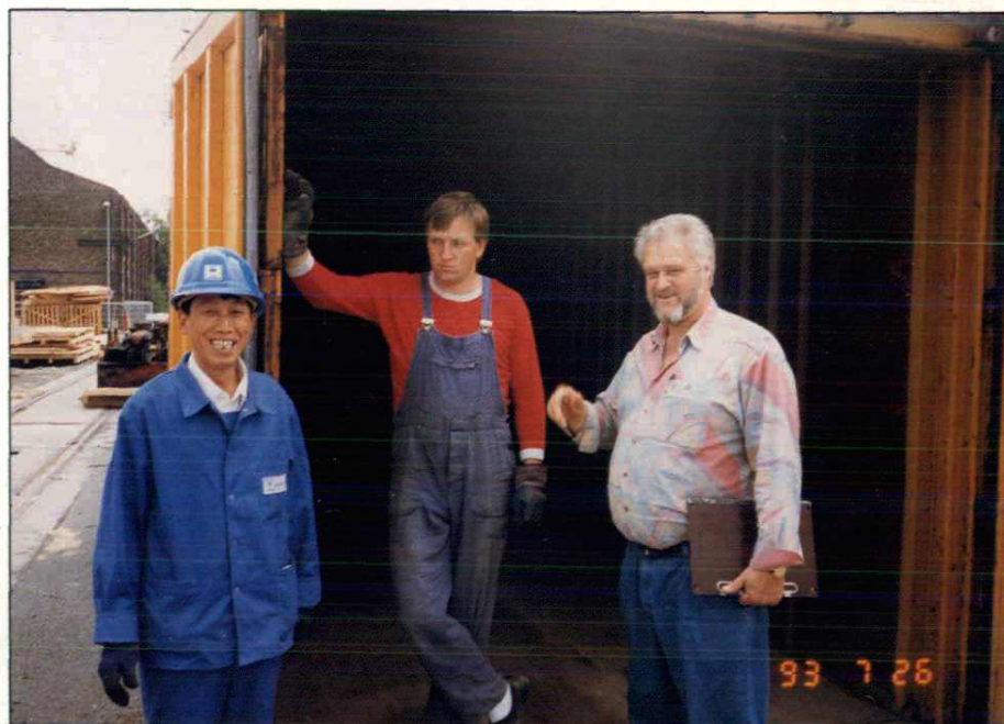
特殊钢厂工作人员与德国柏林钢厂工作人员在德国 50t 电炉拆迁现场
