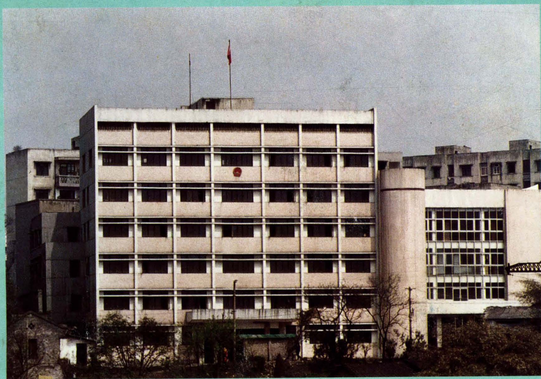
80年代后期，区法院办公大楼外景
