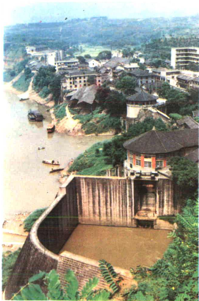
◀ 青居电站外貌
