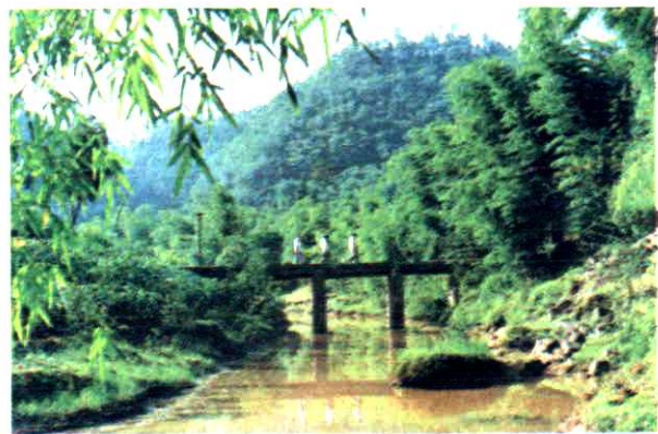
▼ 农村小溪旱桥
